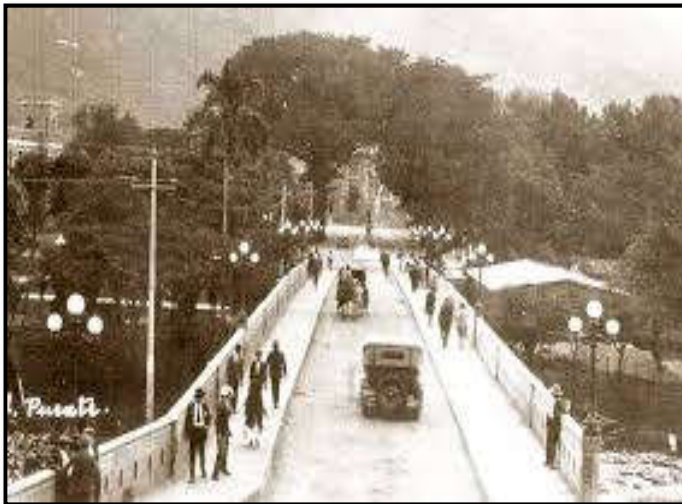
Puente Ortiz antes
